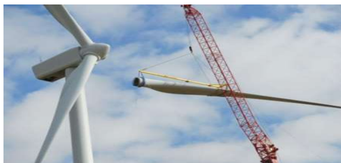
Joonis 2. Tuuleturbiini laba vahetamine
